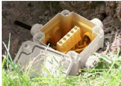
Pilnībā piepildītā kabeļu nozarkārba sasniedz aizsardzības klasi IP68. Kabeļu savienotāji kalpo tikai spriegojuma mazināšanai.
